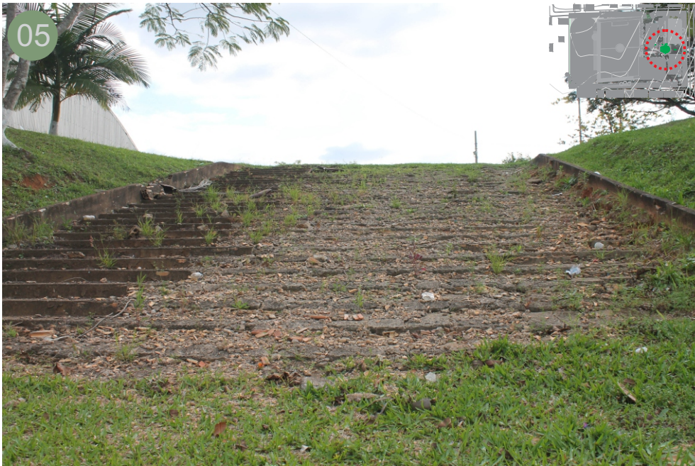
Imagem 90- Escadas de acesso ao complexo deteriorada. Fonte da Autora 2015
